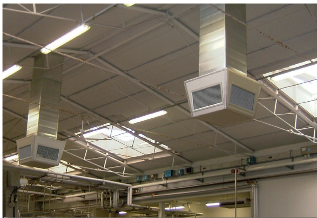
imagen de instalación de equipos BREEZAIR Serie TBA en una fábrica de características similares en Módena, Italia (Granarolo)
